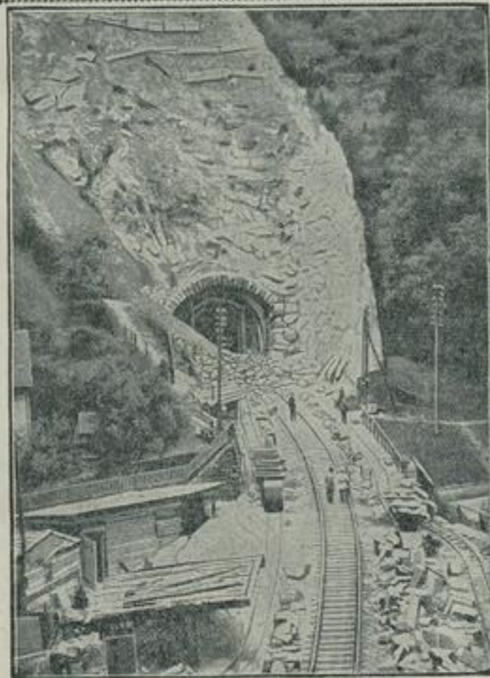
Ein Erdbeben auf der Schwarzwaldbahn ging bei dem unteren Eingang des Triberger Quertunnels zwischen Triberg und Rupsbach nieder. Die Ursache ist in den Tunnelinstandsetzungsarbeiten und in der langen Regenzeit zu suchen.
