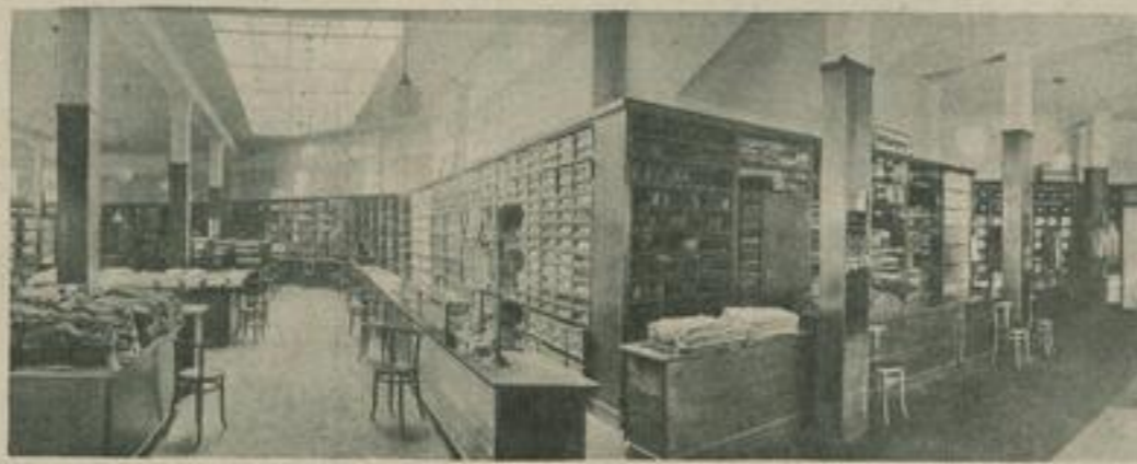
Ein Blick in einige Abteilungen des Erdgeschoßes
