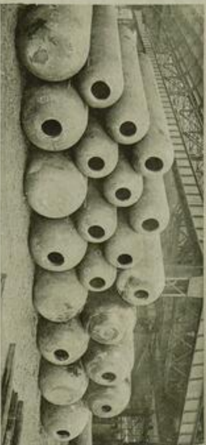
Thyssen-Hochdruckturbine-Trommeln verschiedener Abmessungen
