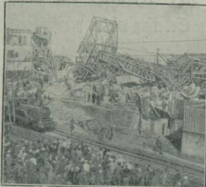
Das Trümmerfeld mit dem umgelegten Fördertrakt.
