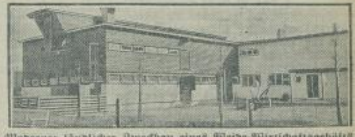
Moderner ländlicher Zweckbau eines Weide-Wirtschaftsgehöftes.
