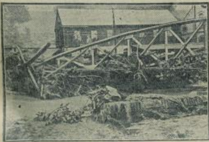
Die Unwetterkatastrophe im Erzgebirge, die zerstörte Bahnbrücke bei Erla.
