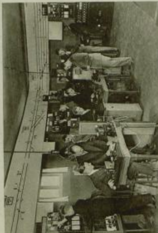
Das Lehrstwerk, in dem alle moderneren Anlagen für Weichenstellung und Signaldienst enthalten sind
