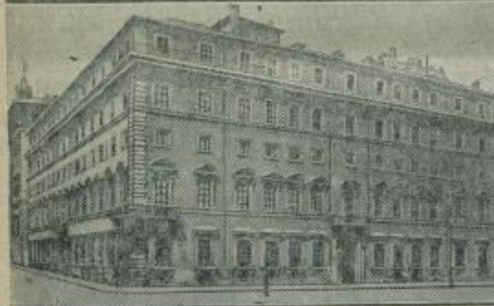
Das deutsche Botschaftsgebäude in Rom, wo Mussolini empfangen werden wird.
