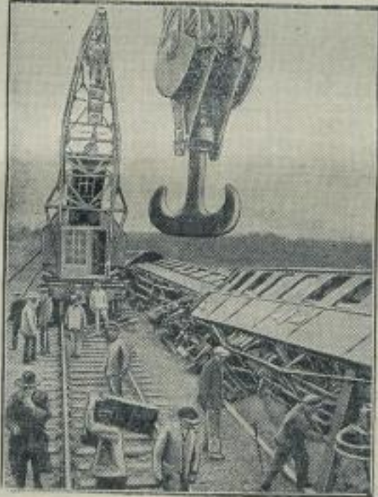
Die Ausräumungsarbeiten in Jüterbog.
