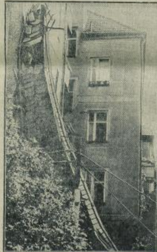
Münchener Kirchturm eingestürzt. Der Turm einer historischen Kirche Münchens, des „Neuhäuser Kirchleins“, neigte sich plötzlich zur Seite und fiel gegen die Hauswand eines benachbarten Hauses.
