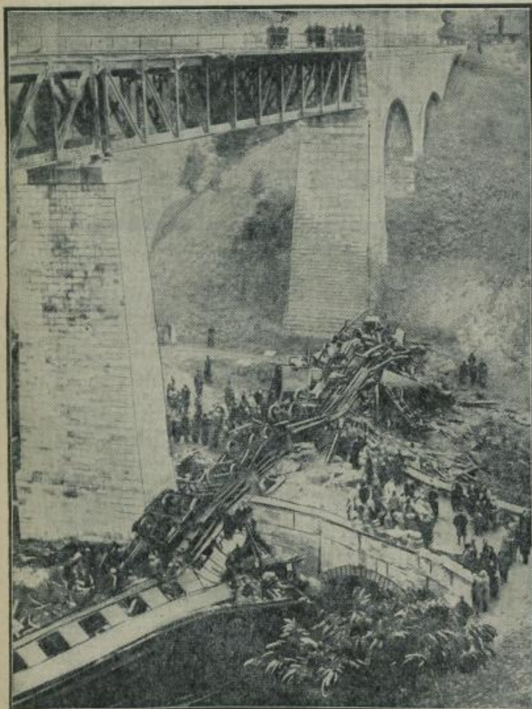
Bild links: Bombenattentat gegen den Budapest-Wien-Expres. Bei der Station Via-Tordago, dreißig Kilometer westlich von Budapest, wurde auf den D-Zug Budapest-Wien-Paris-Ostende ein Attentat verübt. Durch Explosion einer Höllemaschine auf einem mehr als vierzig Meter hohen Viadukt wurde der Zug zur Entgleisung gebracht. Die Maschine und sechs Wa-
