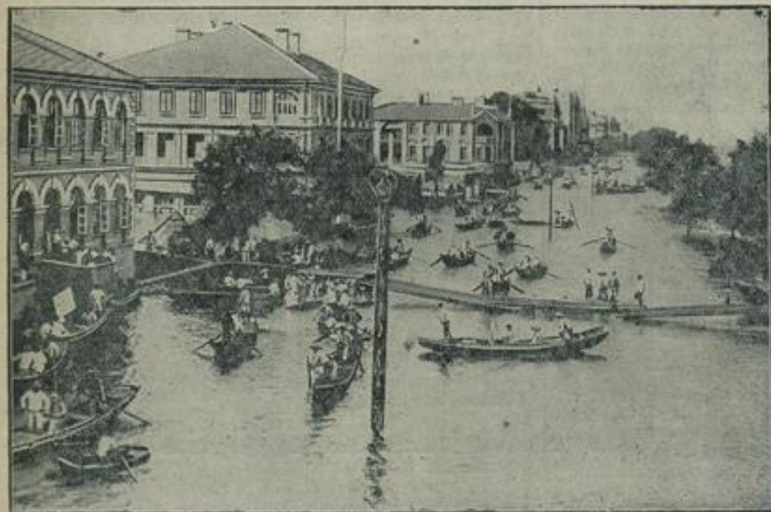
Bild links: Das katastrophale Hochwasser in Hankow, das durch die Ueberschwemmung des Jangtse-Flusses viele tausend Menschen in den Tod gerissen und mehrere Millionen obdachlos gemacht hat. Die vier sichtbaren Gebäude der Auslän-
