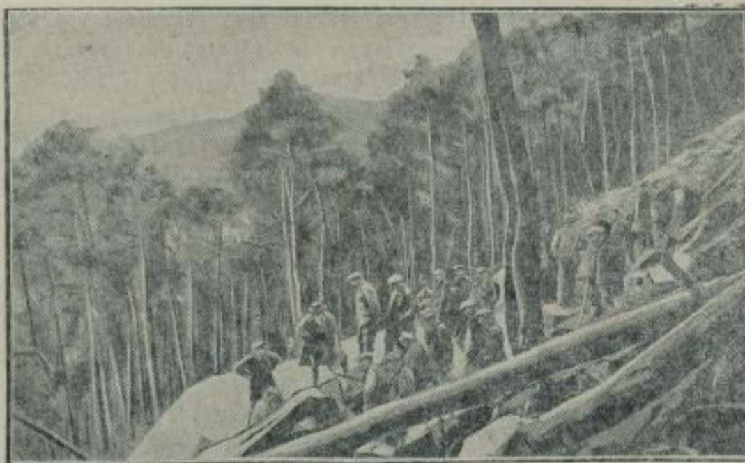
Kanal bis auf eine Breite von drei Metern verschüttet. Der gesamte Schiffsverkehr ist auf lange Zeit unterbunden. — Bild rechts: Der Schauplatz des Sprengungslüdes. Unser Bild gibt
