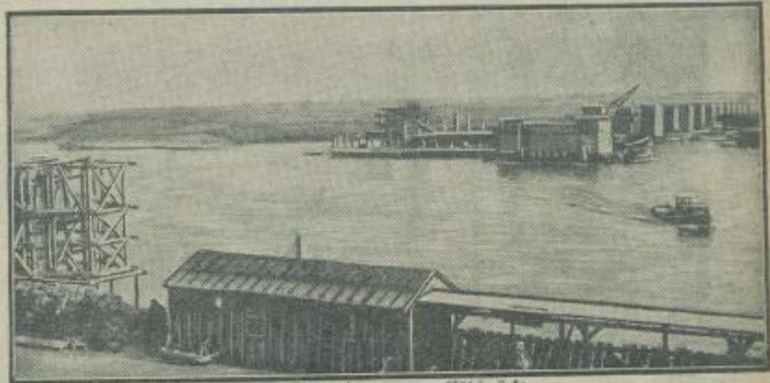
Der Bau einer neuen Eisbrücke
