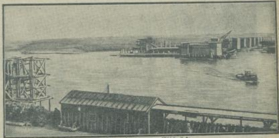
Der Bau einer neuen Eisbrücke
