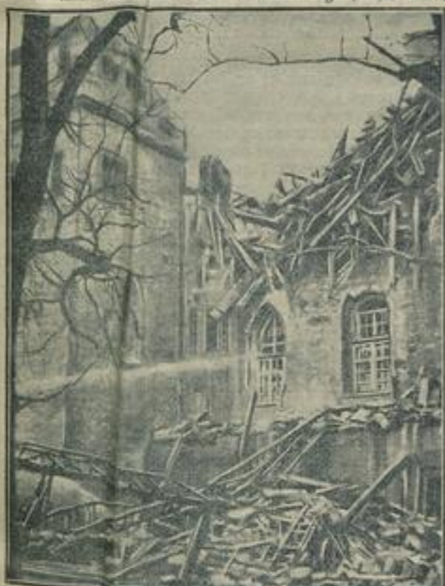
Die Brandruinen des Alten Schlosses in Stuttgart. Eine Aufnahme vom eingestürzten Teil der Südfront des Alten Schlosses mit der Schloßkapelle — ein erschütternder Anblick für alle, die dieses Kleinod Stuttgarts kannten.
