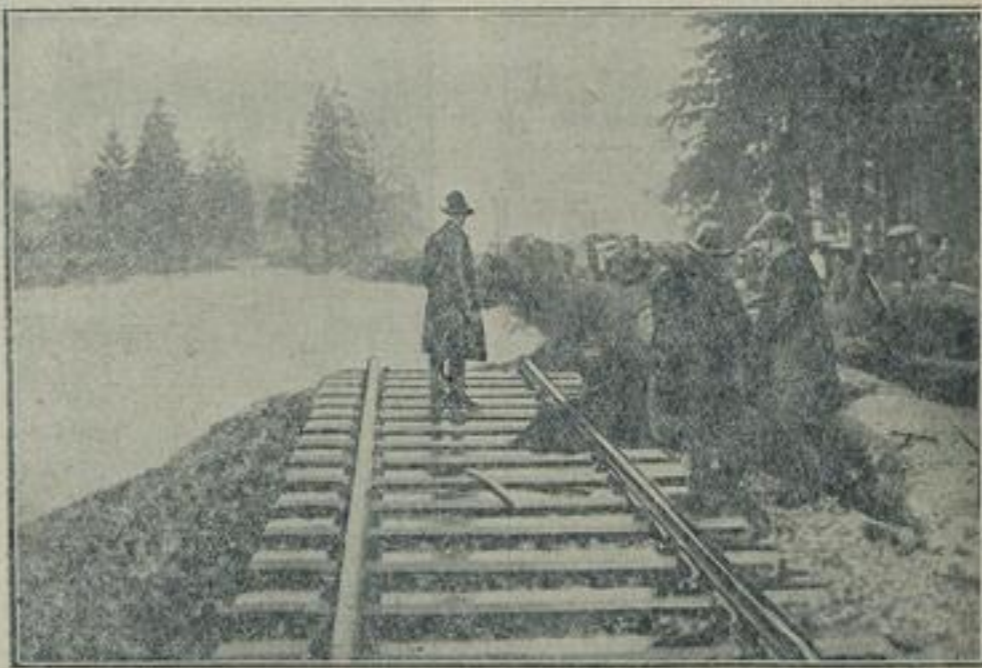
Auch der Harz hat schwer zu leiden. Von der Gewalt der Fluten gibt unsere Aufnahme einen Eindruck. Der Bahndamm der Strecke Goslar-Lautenthal-Clausthal im Harz wurde völlig unterspült und ist zum Teil eingestürzt. Der Verkehr wird durch Autobusse aufrechterhalten.
