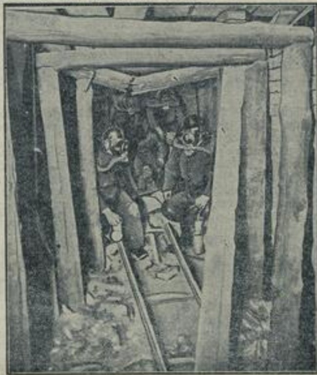
Die Rettungsmannschaft in der Unglückssohle der Karsten-Zentrums-Grube tragen zu Beginn der Bergungsarbeiten einen Verletzten aus dem Stollen.
