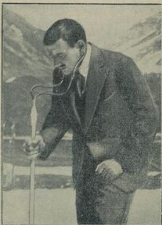
Das Lawinen-Hörrohr. Der Schweizer Arzt Campbell hat auf Grund seiner Erfahrungen bei Lawinenstürzen einen Apparat konstruiert, mit dem sich auf akustischem Wege die Lage eines von der Lawine verschütteten feststellen läßt. An einer zweieinhalb Meter langen und zwei Zentimeter starken Eisenröhre, die in ihrer ganzen Länge mit kleinen Löchern versehen ist, hängen oben an einer metallenen Resonanzglocke zwei Schläuche. Der Apparat wird in die Lawine gesteckt und bringt die Laute und Geräusche der Verschütteten verstärkt zu Gehör, so daß man durch Absuchen innerhalb kurzer Zeit die Lage der Verunglückten feststellen kann.
