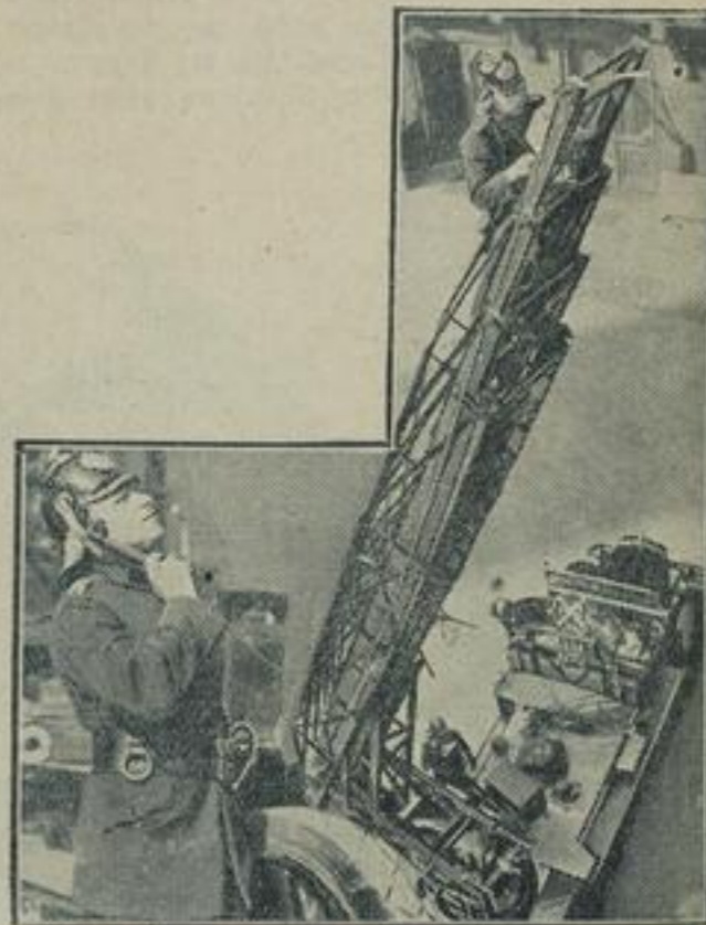
Feuerwehrleiter mit Telephon. Die neuen mechanischen Riesentelephone der Feuerwehr sind mit Telephon ausgerüstet, da eine Verständigung zwischen den auf der Leiter arbeitenden Feuerwehrleuten und ihren Kollegen auf dem Erdboden auf einem anderen Wege nicht mehr möglich ist. Unsere Zusammenstellung zeigt, wie der auf den obersten Sprossen der Leiter arbeitende Feuerwehrmann (rechts) zu seinem Kollegen, der unten am Wagen steht (links) sich mittels des Telefons verständigt.
