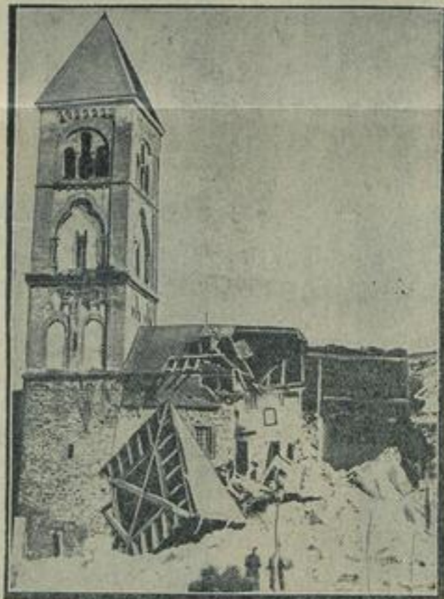
Ein Baudenkmal aus dem 12. Jahrhundert eingestürzt. Der etwa zehn Meter hohe Südturm des berühmten Klosters Schönstert in Ballenar am Rhein, eines der schönsten historischen Wahrzeichen der fast tausendjährigen Stadt, stürzte plötzlich in sich zusammen. Der Südturm war mit dem Ostturm (links) der letzte Ueberrest des im 12. Jahrh. erbauten Klosters.
