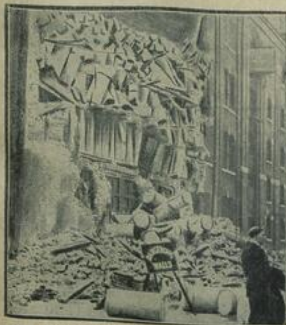
Ein Haus zeigt seine Eingeweide. Vor einigen Tagen stürzte in der Londoner Innenstadt plötzlich die Wand eines Lagerhauses ein, so daß man in das Innere des Gebäudes blicken konnte. Glücklicherweise wurde niemand verletzt, jedoch stürzten die Waren — Papierrollen und Kisten — auf die Straße.
