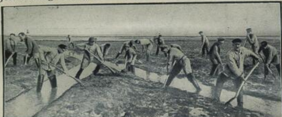
Die Stadt Hamburg hat einen Trupp Arbeitsloser zum freiwilligen Arbeitsdienst an die Nordseeküste entsandt, um hier Landgewinnung vorzunehmen. Durch diese Maßnahme können lange gehegte Pläne, die bisher immer an der Kostenfrage scheiterten, endlich in Erfüllung gehen. Unsere Aufnahme zeigt die Truppe beim Ausheben von Gräben bei Cuxhaven, in denen sich bei Ebbe der abgelagerte Schlamm sammelt.
