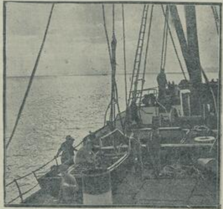
Die Hebungsarbeiten an der „Niobe“. Immer noch wird an der Vergung der „Niobe“ gearbeitet. Unser Bild zeigt den Vergungsdampfer „Simson“ mit dem Blick auf die Unglücksstelle, wo die Hebeschiffe liegen.
