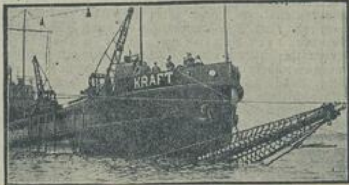
Schwierige Bergungsarbeiten am „Niobe“-Brak. Die Bergungsarbeiten am Brak des gesunkenen Segel- schiffes „Niobe“, die in der Heilendorfer Bucht des Kieler Hafens vorgenommen werden, waren bereits so weit gediehen, daß ein Teil des Vorderbühls aus dem Wasser hervortrat. Später jedoch sackte das Brak wieder ab, so daß nur noch der Alfverbaum — wie unser Bild zeigt — zu sehen war.
