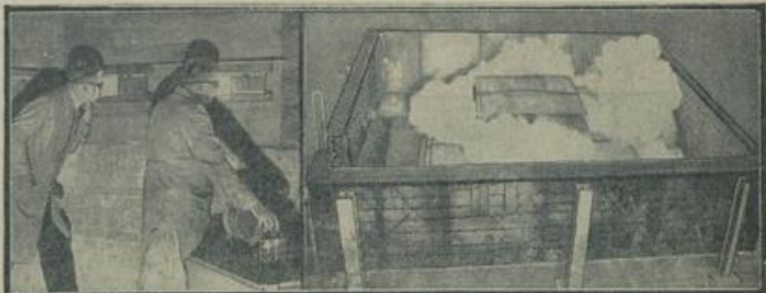
Bomben werden vernichtet. Unser Bild berichtet von einem wenig bekannten Arbeitsgebiet der Chemisch-Technischen Reichsanstalt in Berlin: der Unschädlichmachung von Bomben, die bedauerlicherweise in letzter Zeit eine besondere Rolle im politischen Leben spielten. Das Bild rechts zeigt eine eigens für diesen Zweck gebaute Grube, in der soeben eine Bombe zur Explosion gebracht wurde. Riesige Stahlpanzer schützen die Grube vor der Zerstörung. Links: ein Blick in den Unterstand, in dem die Zündung bei den Explosionen vorgenommen und der Vorgang selbst beobachtet wird.
