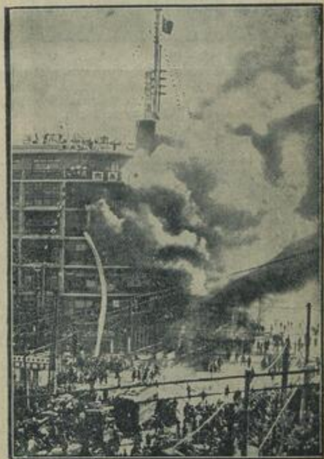
Das erste Bild von der Brandkatastrophe in Tokio, die kürzlich in dem größten Warenhaus der japanischen Hauptstadt ausbrach und fünfzehn Todesopfer und achtzig Schwerverletzte forderte.
