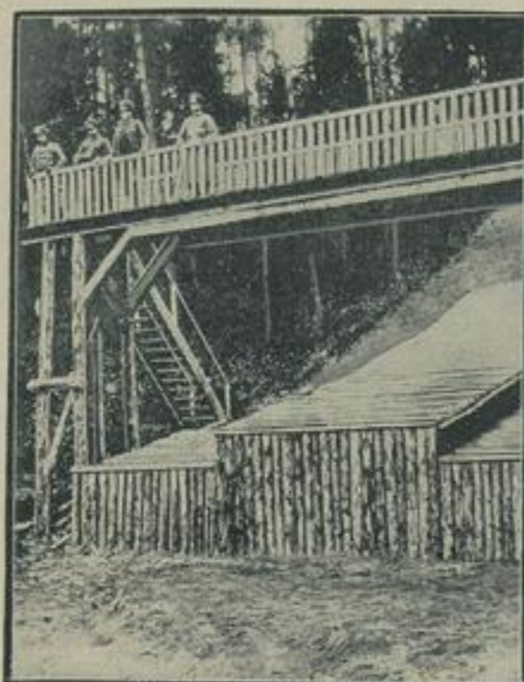
Die Reichswehr baut die größte Sprungschanze Ostpreuhens. In Passenheim ist jetzt eine neue Skisprungschanze fertiggestellt worden, die im Januar eingeweiht werden soll und die größte Sprungschanze Ostpreuhens ist. Diese Schanze ist von einem Reichswehrkommando aus Ortelsburg erbaut worden; sie hat vom Abprung bis zum Aufsprung eine Länge von 45 Meter und besitzt als Neuerung eine 12 Meter lange Brücke über den Sprungfließ, von der aus 50 Zuschauer die Sprünge verfolgen können.
