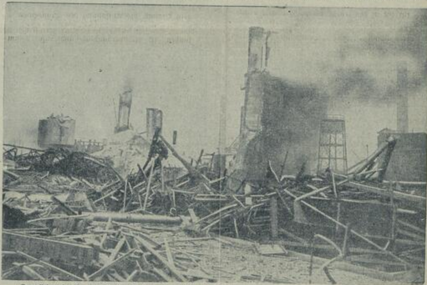
Der Schauplatz der entsetzlichen Katastrophe. Bild auf die völlig zerstörten Fabrikanlagen der Neunkirchner r Eisenwerke.
