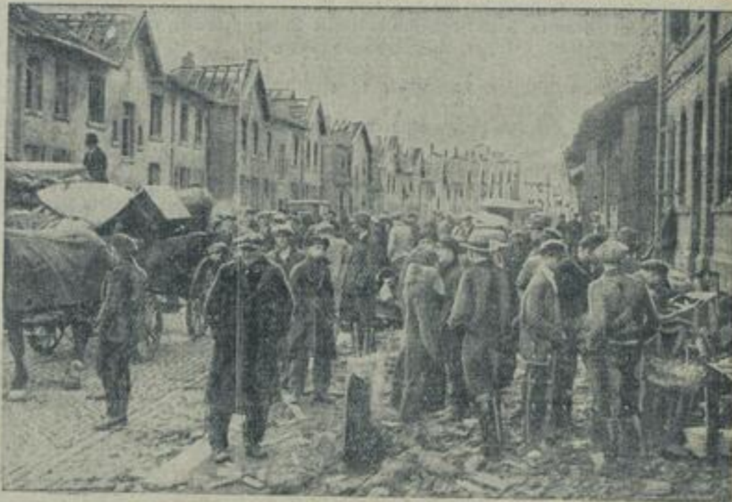
In den Straßen der zerstörten Stadt. Eine Straße der Unglücksstadt Neunkirchen: durch den gewaltigen Luftdruck sind hier sämtliche Dächer abgedeckt worden.
