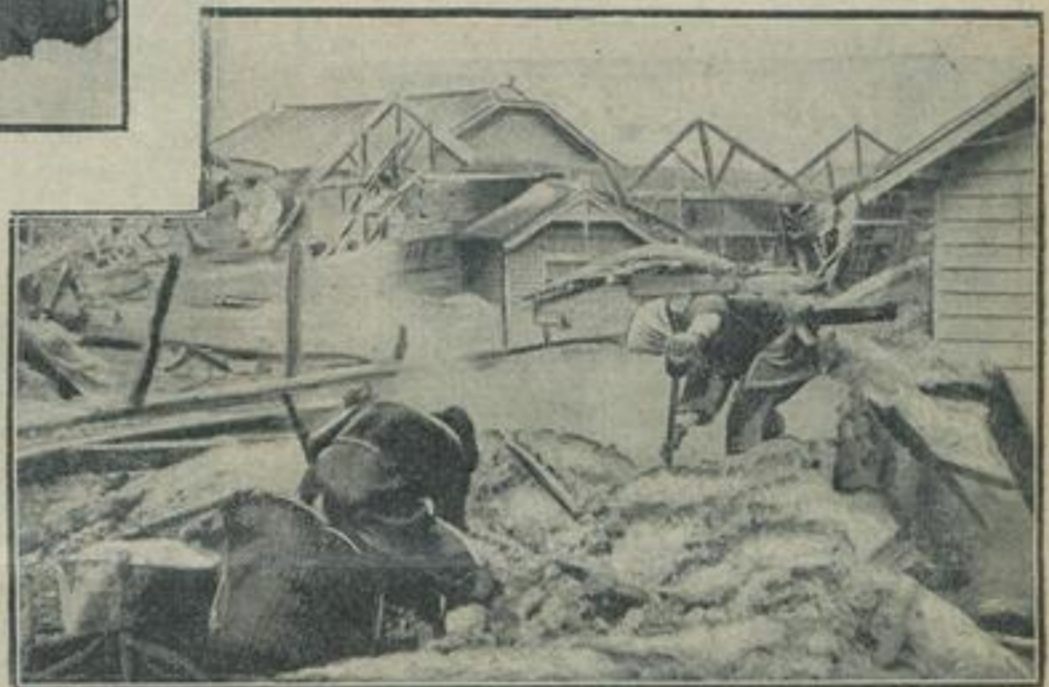
Zerstörte Wohnstätten überall.
