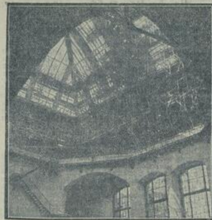
Wiederaufbauarbeit am Reichstagsgebäude.
