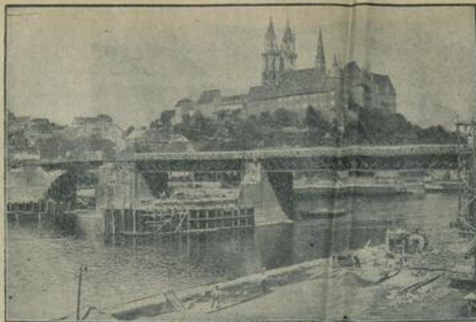
Meißen bekommt eine neue Elbbrücke.
