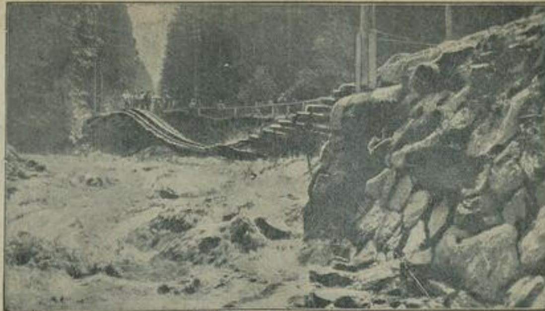
Unwetter im Berner Oberland. Eine Aufnahme von den furchtbaren Wirkungen eines Wollenbruchs, der den Fluß Lutschine bei Lauterbrunnen in der Schweiz in ein reißendes Gewässer verwandelte, so daß der Bahndamm der Berner Oberlandbahn — wie man sieht — vollkommen zerstört wurde.
