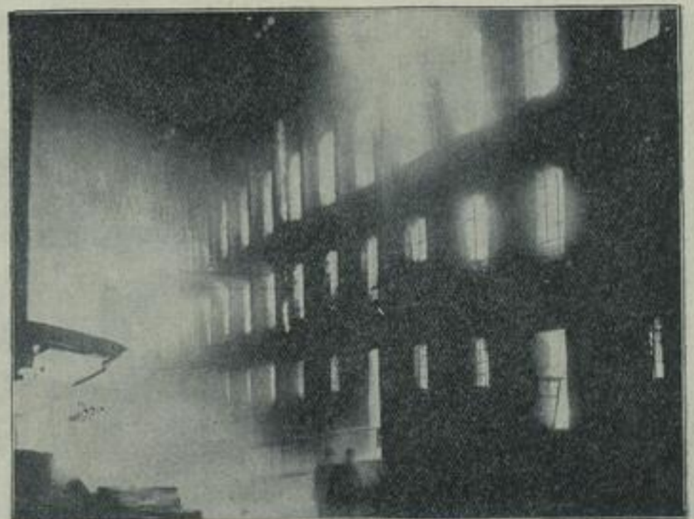
Der nächtliche Riesenbrand in Karlsruhe.
