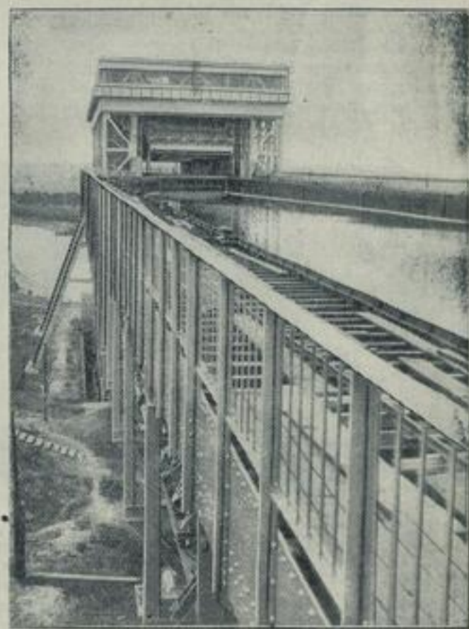
Schiffshebewerk Niederfinow nahezu fertiggestellt.
