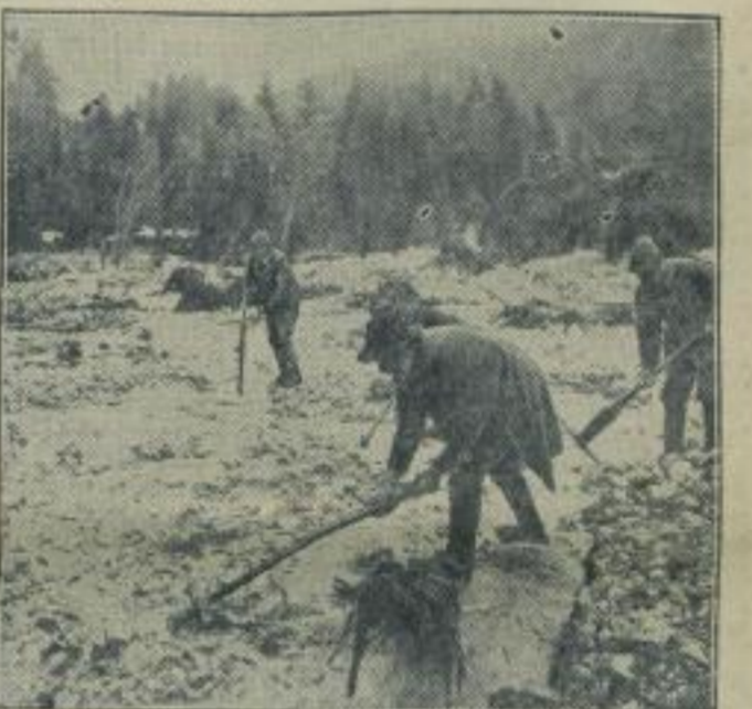
Im Katastrophengebiet am Wendelsberg. Dorfbewohner versuchen den durch Sandmassen und Geröll verschütteten Gassenbach zu räumen und ihm sein altes Bett wiederzuschaffen.
