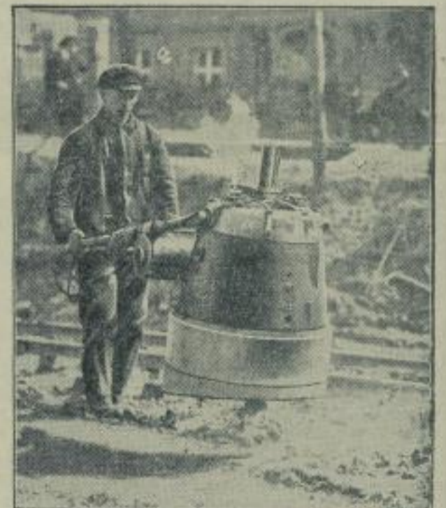
Ein neuer Straßenstampfer. Nur neuerdings bei Straßenbauarbeiten immer mehr Verwendung findet: mittels eines Benzol-Explosionsmotors wird der Stampfer mechanisch in Betrieb gesetzt und kann trotz seines Gewichts von zehn Tonnern von einem einzigen Mann bedient werden.
