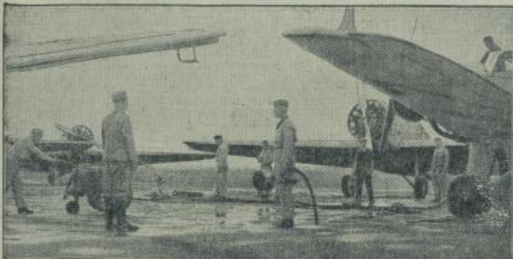
Unsere Luftwaffe: Tanten der Maschinen. Sobald eine Schicht des Flugdienstes vorüber ist, erhalten die leeren Brennstofftanks der Maschinen neue Füllung aus explosionsfester angelegten Behältern des Flugplatzes. (Eberlbild — M.)
