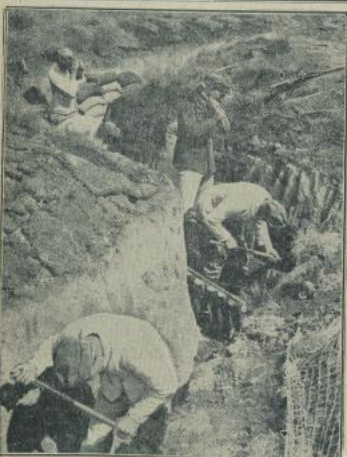
Pioniere beim Schützengrabensbau.
