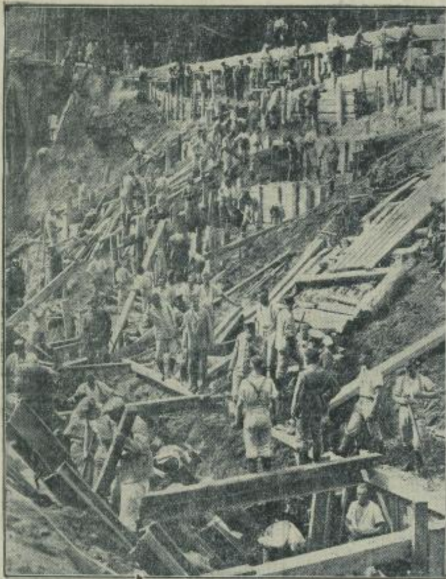
Der Anglidsstunnel Tag und Nacht arbeiten mit vorbildlicher Energie und Einsatzbereitschaft Pioniere, Feuerwehr, Technische Rotbilde und die Spezialarbeiter aus dem Ruhrgebiet und Hannover an
