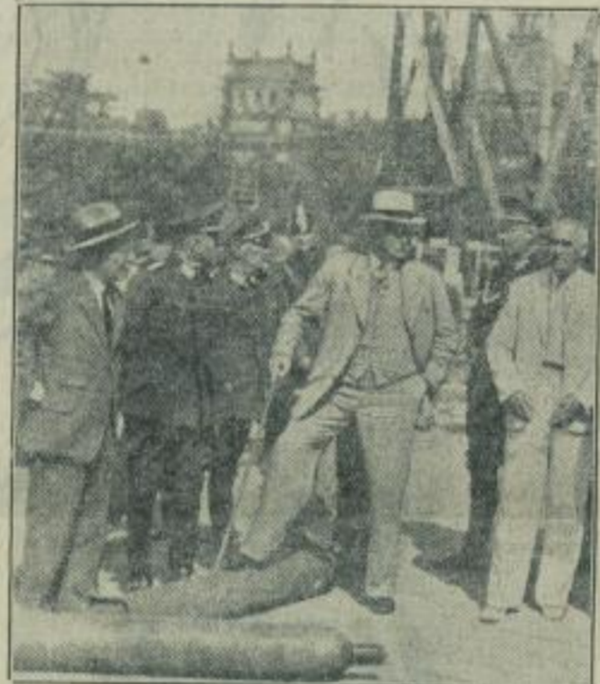
Minister verfolgen die Rettungsarbeiten am Unglückstunnel. Reichswehrminister Eiz von Riebenach (links), Generaldirektor Dörpmüller (Mitte) und Reichsinnenminister Dr. Frick (rechts) weilen am Unglückstunnel in der Hermann-Göring-Straße zu Berlin und verfolgen persönlich die Rettungsarbeiten. (Eherl Bilderdienst — M.)
