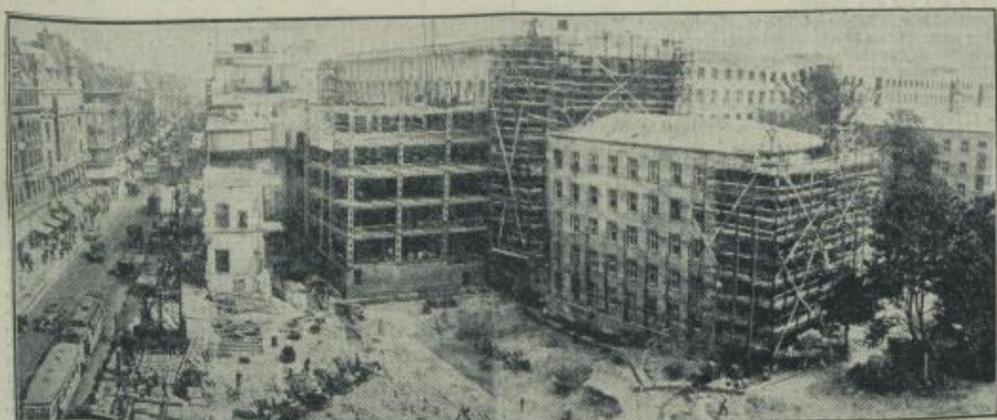
Der Neubau des Reichsluftfahrtministeriums. Der Bau des neuen Reichsluftfahrtministeriums, das zwischen der Leipziger, Wilhelm- und Prinz-Albrecht-Straße in Berlin entsteht, schreitet rüstig fort. (Eberl Bilderdienst — M.)
