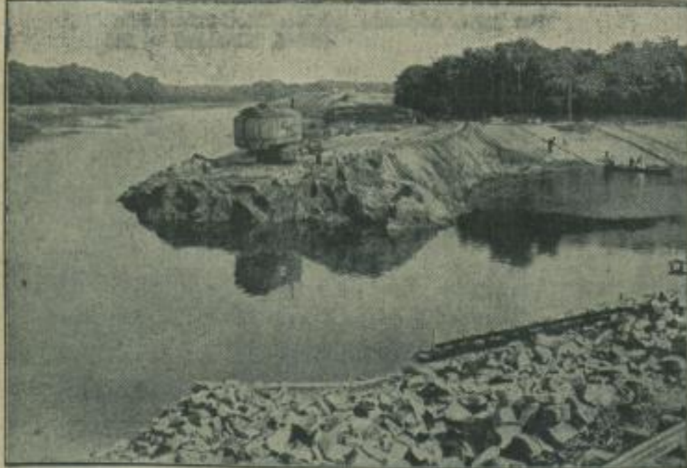
Die Soole erhält eine neue Mündung. Bei Barby an der Elbe ist ein neues Soalebett geschaffen worden. Die Erdwand, die den neuen Flußlauf von der Elbe trennte, ist kürzlich am unteren Ende durchstochen worden. Der
