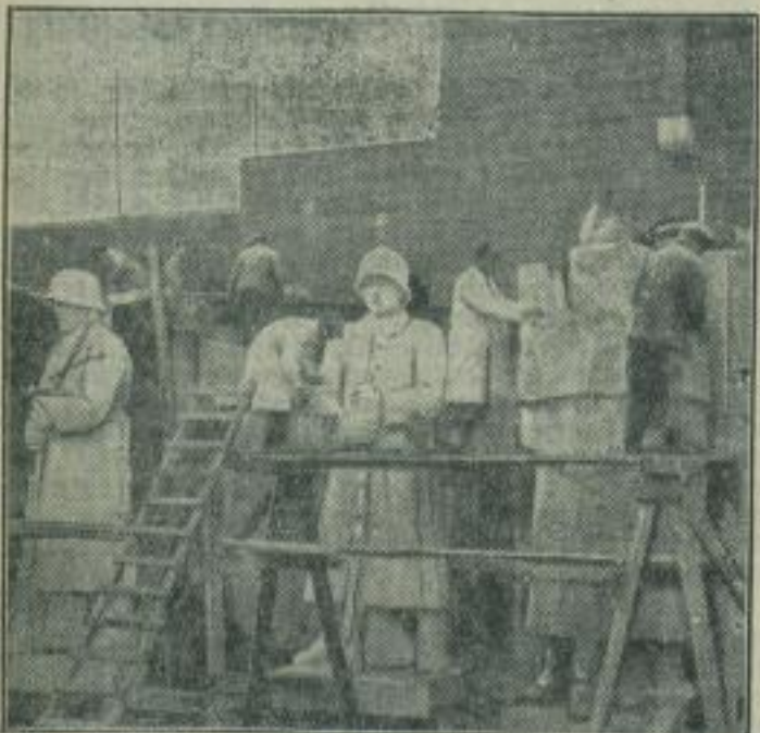
Die Hindenburggrube im Tannenberg-Nationaldenkmal fertig.
