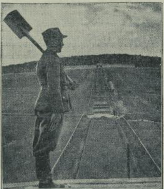
Büdeberg ist für den Erntedankfest gerüstet. Bild auf die fertiggestellten Trübenanlagen auf dem Büdeberg. (Weltbild — M.)
