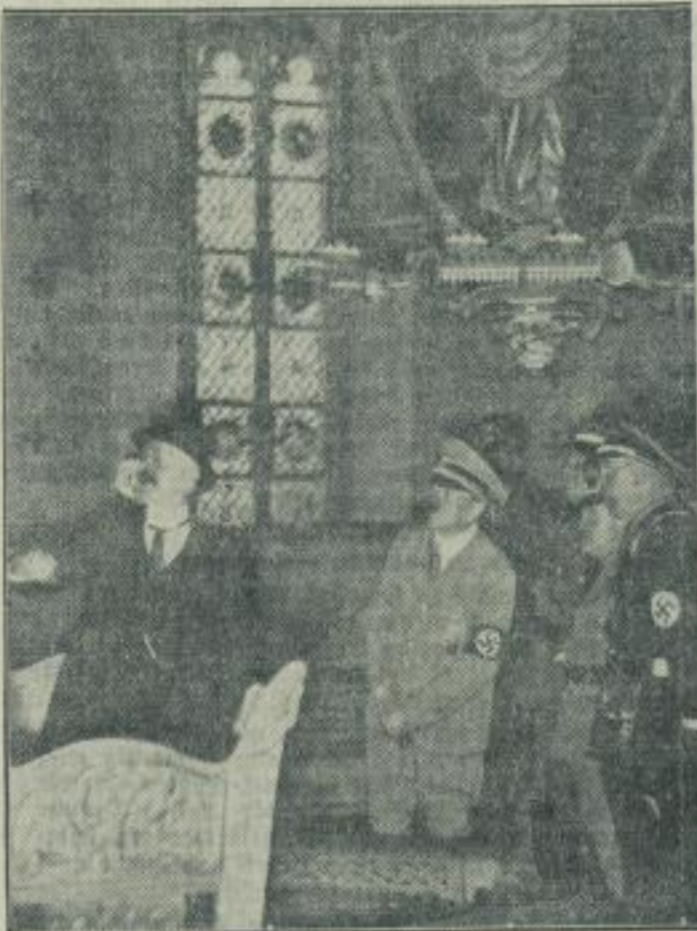
Der Führer besichtigte die Marienburg. Unter Führung des Oberbaurats Schmitt (links) besichtigte der Führer zusammen mit Gauleiter Koch (rechts neben ihm) die Marienburg. (Heinrich Hoffmann - M.)
