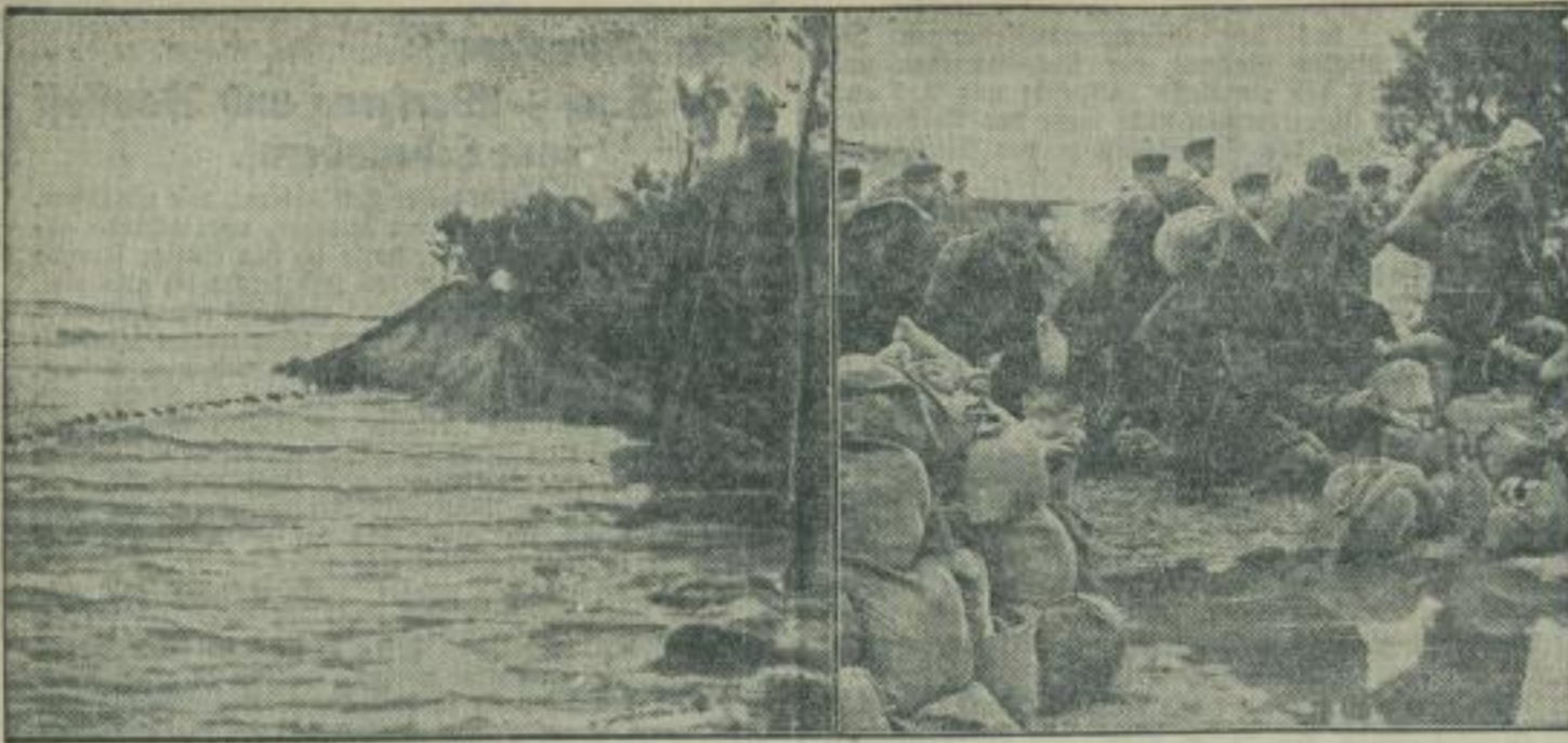
Am Schauplatz der Sturmverbesserungen an der Ostsee. Das Bild links gibt einen Begriff von den Vorarbeiten, die der schwere Nordoststurm an der Ostseeküste angerichtet hat; beim Ostseebad Zempin brach der Damm in einer Breite von 60 Meter, so daß die dahinterliegenden Wäldungen über- schwemmt wurden. An den aus dem Wasser herausragenden Dammbefestigungen erkennt man die ursprüngliche Dammlinie rechts: Pioniere bei Befestigungsarbeiten im bedrohten Gebiet. (Weltbild — M.)
