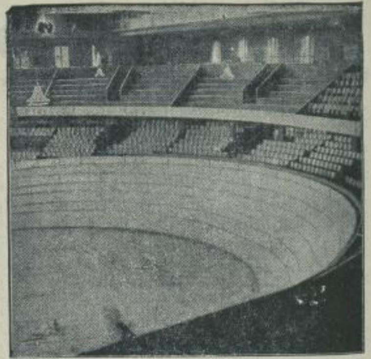
Die schnellste Hallenbahn der Welt in der Deutschlandhalle. Die neue Radrennbahn in der Deutschlandhalle steht, und bereits in den ersten Tagen der kommenden Woche werden die Rennfahrer das Training aufnehmen. Die 210-Meter-Holzbahn wird die schnellste Hallenbahn der Welt sein. (Schnitzer — M.)
