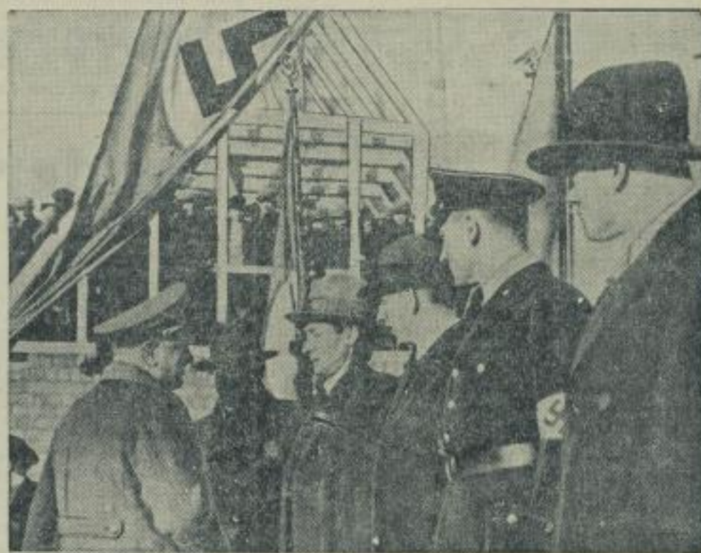
Weibe der Dr. Robert Leo-Siedlung. Im Notgebiet des Kreises Magdeburg in der Elbe, dessen Bevölkerung durch die Stilllegung der zahlreichen Steinbrüche in immer tieferem Not geraten ist, sind jetzt durch den nationalsozialistischen Aufbauwillen in kurzer Zeit an die Stelle der Elendwohnungen schmucke, saubere, hygienische Siedlungshäuser gesetzt worden. Die ersten beiden Teile dieser Siedlungen sind jetzt fertiggestellt, das dritte wird festlich eingeweiht werden können. Der Reichsorganisationsleiter weihte die „Dr. Robert Leo-Siedlung“ persönlich: im Bilde sehen wir Dr. Leo mit den Siedlern. (Weltbild — M.)
