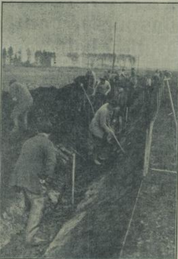
Überall sind Arbeiter anzutreffen, die Entwässerungsarbeiten leisten.
