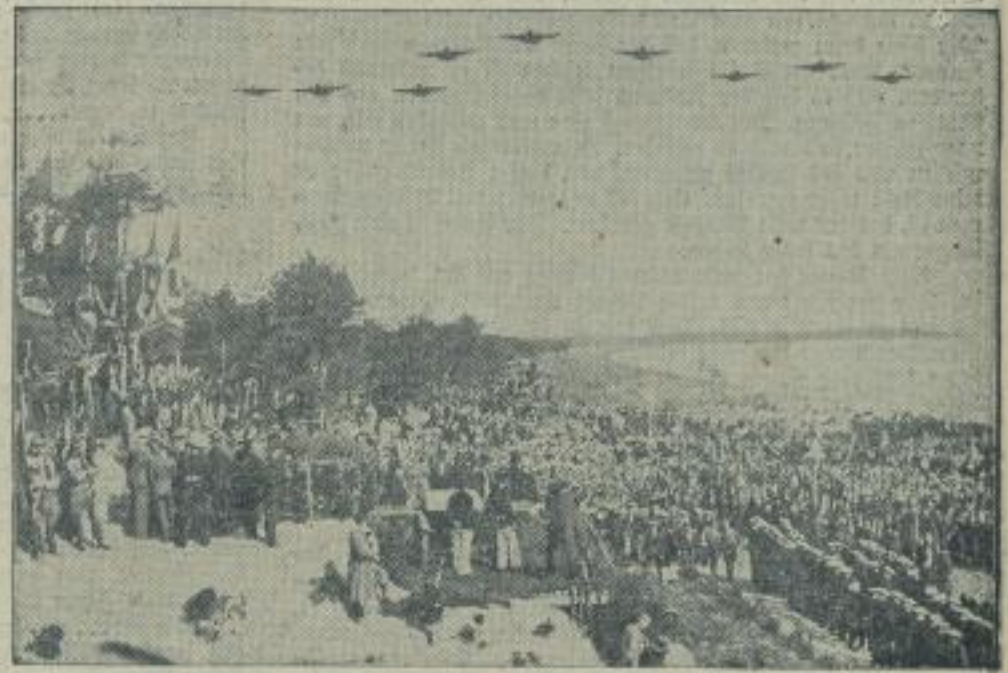
Grundsteinlegung zum ersten „Kraft-durch-Freude“-Seebad. Zwischen Binz und Sahnitz wurde durch Dr. Leo der Grundstein zum ersten „Kraft-durch-Freude“-Seebad gelegt. In zwei bis drei Jahren werden hier 20 000 „Kraft-durch-Freude“-Urlauber Erholung finden. Vier weitere Bäder sollen später errichtet werden. Während der Grundsteinlegung zog eine Flugzeugstaffel über dem Strand ihre Kreise. (Eberl-Bilderdienst — M.)
