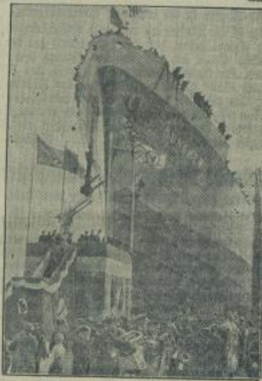
Das neue Motorluftschiff „München“ lief auf der Werft des Bremer Vulkan dieser Tage vom Stapel. Vor einigen Wochen ist das Schwesterluftschiff „Rürnberg“ auf derselben Werft vom Stapel gelassen. (Norddeutscher Lloyd — M.)
