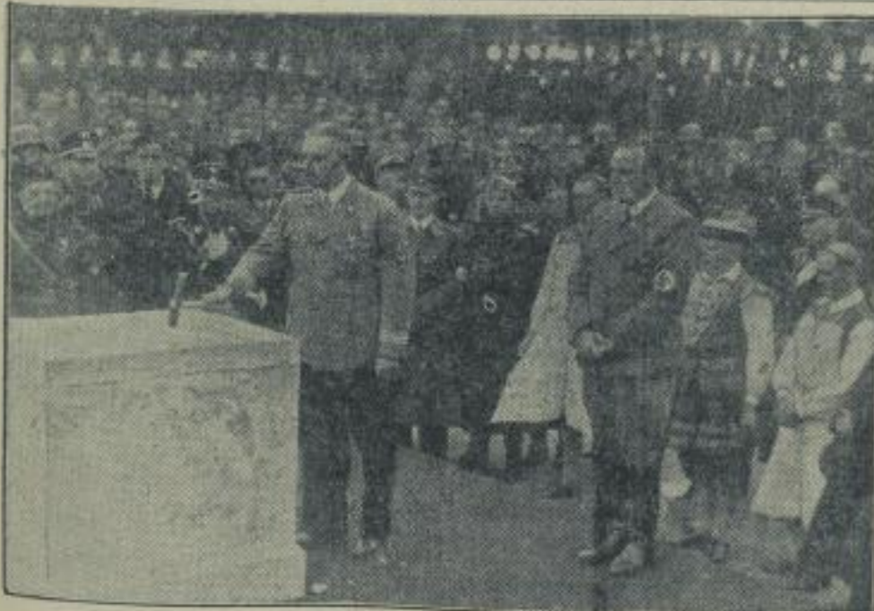
Der Grundstein zum „Haus des Rechts“ gelegt. In München fand in Gegenwart vieler in- und ausländischer Ehrengäste die Grundsteinlegung des „Hauses des deutschen Rechts“ durch Reichserziehungsminister Dr. Rust statt; Reichsminister Dr. Rust führt den Hammer Schlag aus; rechts von ihm Reichsminister Dr. Frank. (Eberl Bilderdienst — M.)
