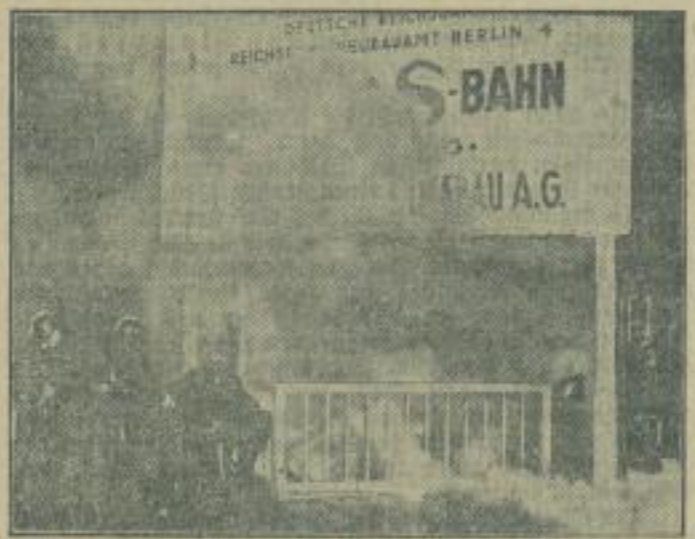
Vernachlässigter Eingang zu der unterirdischen Baustelle. Durch viele Klöße pumpte die Feuerwehr Wasser in den brennenden Schacht. (Scherl.)
