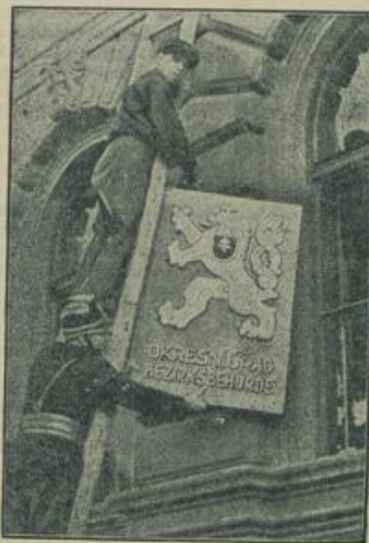
Tschechenwappen verschwindet. Ueberall in den nunmehr wieder deutschen Gemeinden im Sudetenland — so hier in Prachatitz — verschwindet jetzt an den Bürgermeistereien das tschechische Wappen. (Werbild-Wagenborg W.)
