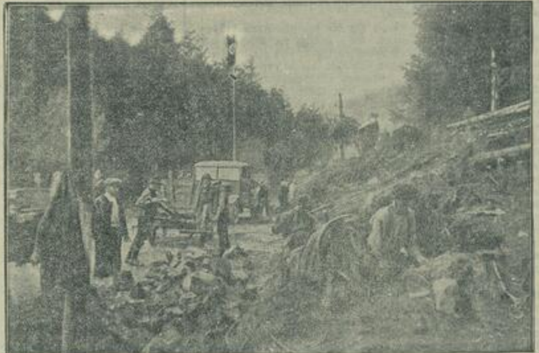
Großzügige Aufbauarbeiten im befreiten Sudetenland. Unmittelbar nach dem Einmarsch der deutschen Truppen wurden im befreiten sudetendeutschen Gebiet die Aufbauarbeiten in Angriff genommen. Tausende von Sudetendeutschen, die viele Jahre arbeitslos waren, finden schon jetzt bei großzügigen Straßenbauten wieder Arbeit und Brot. — Straßenbauarbeiten im Seegrund bei Altenberg. (Weltbild-Wagenborg-M.)
